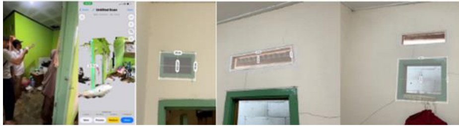
Gambar 5. Proses Identifikasi Kerusakan Bangunan
