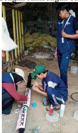
Gambar 1 Pemasangan komponen convex mirror
