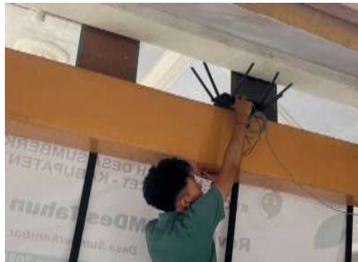
Gambar 4. Pemasangan router atau Wifi lokal Kipin
