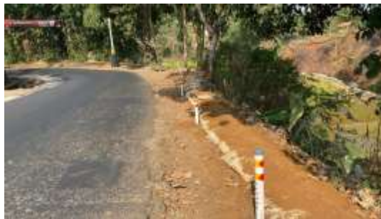
Gambar 2. Kondisi reflektor setelah pemasangan pada siang hari
