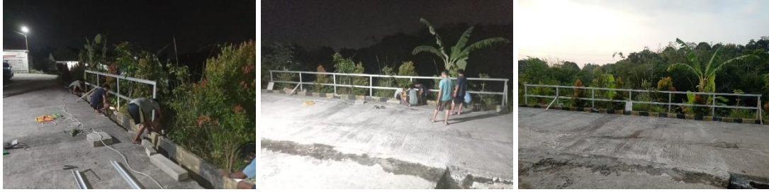
Gambar 7. Pemasangan Rangka Pagar Pengaman di Jalan Walisongo 1
