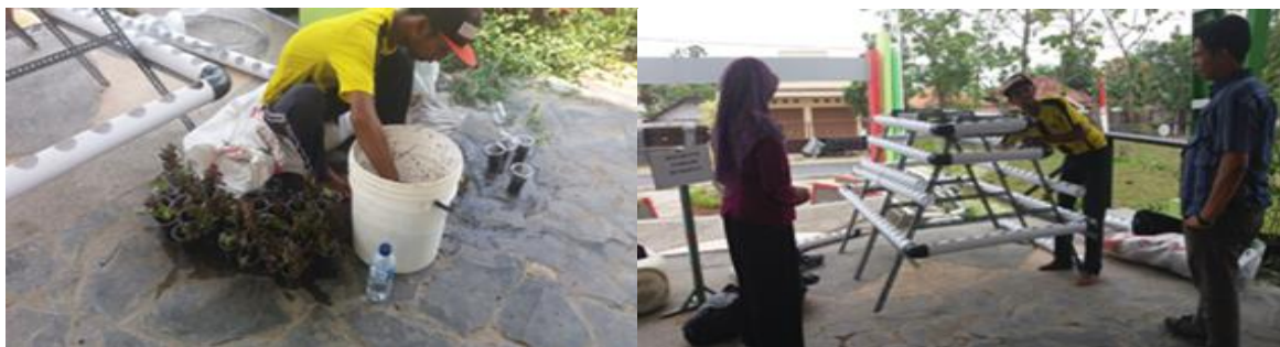
Gambar 4. Pembuatan Instalasi Hidroponik
