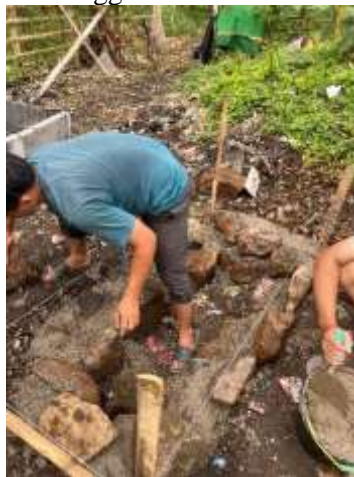
Gambar 2. Tahap pembangunan rocket stove
