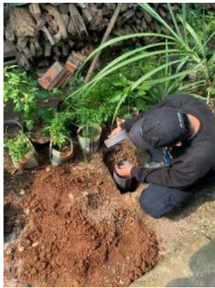
Gambar 3 Proses Pembuatan Biopori
