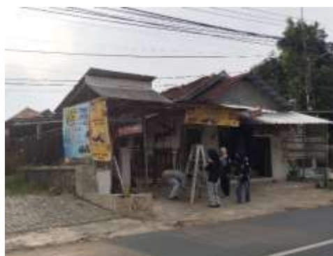
Gambar 4. Pemasangan Banner Baru
