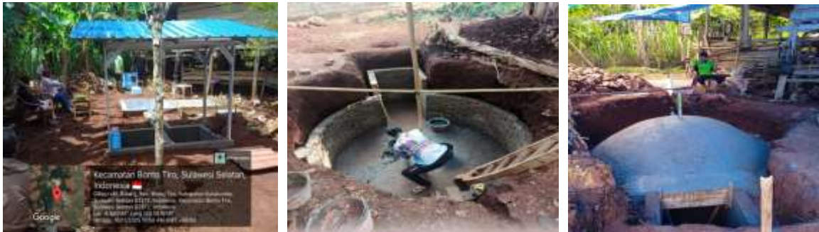
Gambar 1. Pembangunan Instalasi Digester Biogas
