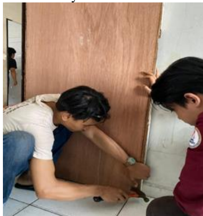
Gambar 5. Perbaikan Pintu Ruang Kelas
