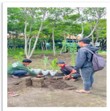
Gambar 8: Kerja Bakti Mahasiswa dalam Pemasangan Paving
