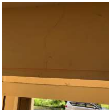
Gambar 1. Investigasi Visual Lendutan Balok
