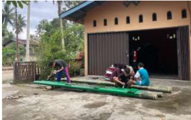
Gambar 3. Pembersihan, pengecatan, dan perakitan komponen gapura.
