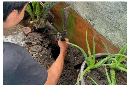
Gambar 4. Proses Pemasangan Pipa Biopori
