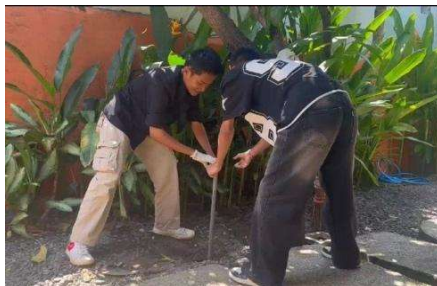
Gambar 3. Proses Penggalian Lubang Biopori
