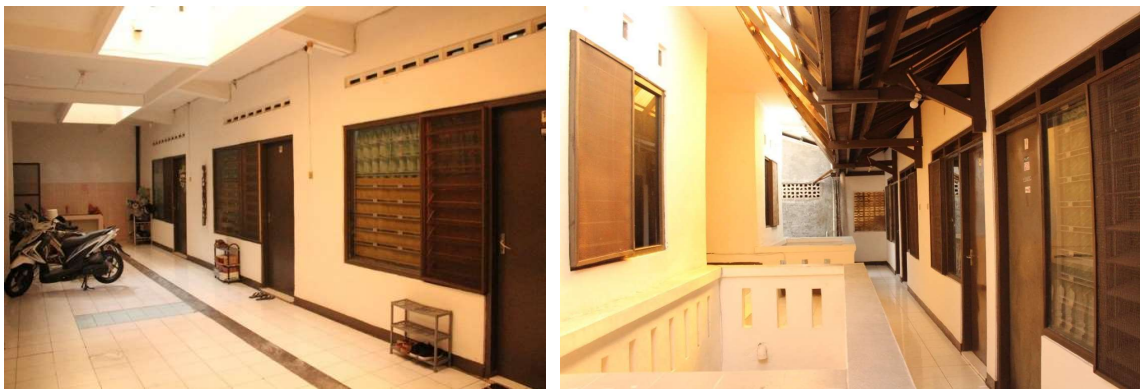
Gambar 3. Kondisi Bangunan Kost Kania
