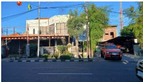
Gambar 1. Dokumentasi Tampak Depan Kantor BPBD Kab Sidoarjo Sumber: Penulis
