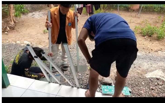
Gambar 4. Proses Pemasangan Plang di Persimpangan Kampung Kasa 1 dan Kasa 2
