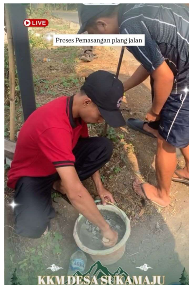
Gambar 3. Proses Pengecoran Tiang Plang oleh Mahasiswa dan Warga
